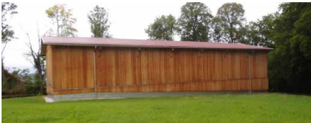
Hochbehälter der städtischen Wasserversorgung am Harzberg
